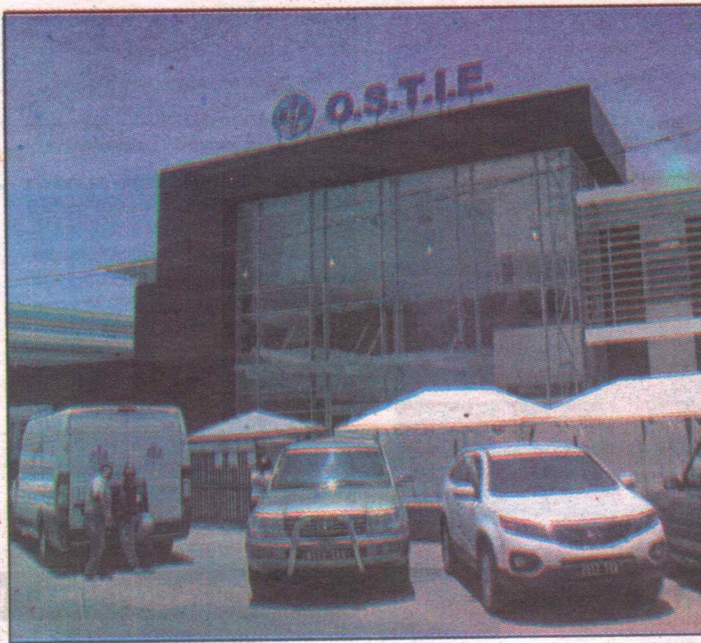
Le nouveau centre de l'Ostie à Ambohimanarina.
